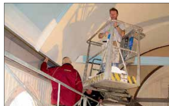
Det er høyt under taket i kirka, men Arne Ugseth arbeider trygt i liften.
