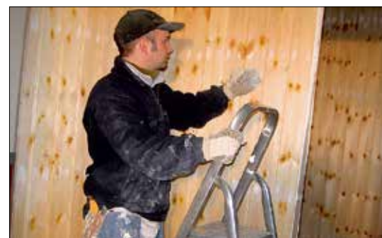
Espen Fløan Kristiansen spakler over spikerhoder og pusser for grunning og maling av stellerrommet.
