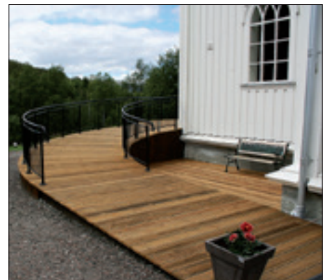
I en naturlig forlengelse på inngangspartiet, har det blitt en stilig handikappinngang.
