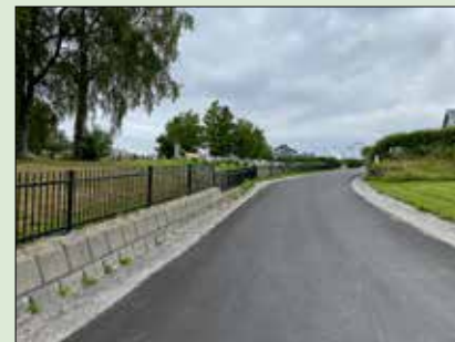
Nytt gjerde og ny asfalt.
