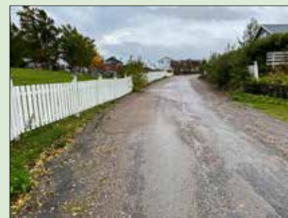
Gammelt gjerde, før asfaltering.
