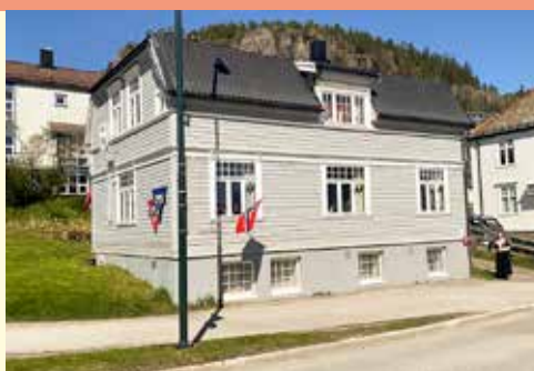
Overhallsveien 1, eller KFUK-KFUM huset.
