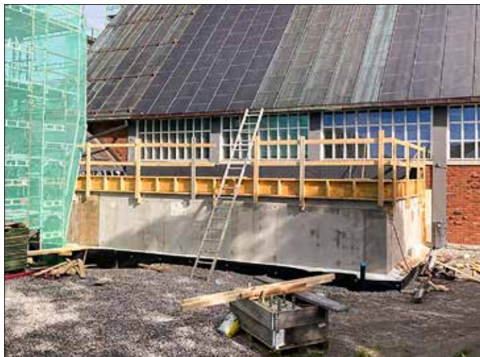
Renoveringen av Namsos kirke går etter planen. Nytt sanitærtbygg med 4 toaletter, kjøkken og renholdsrom er under oppføring.
