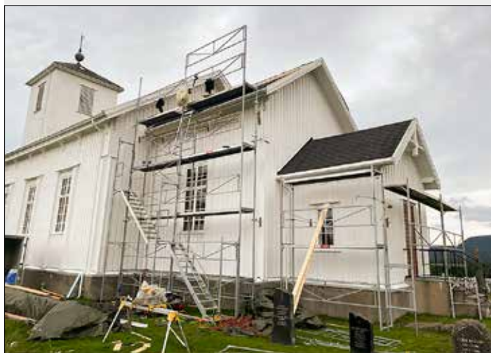
I Klinga er det utført omfattende vedlikehold av kirka utvendig. Taket på korpartiet er skiftet, råteskader er utbedret, det er lagt på nye beslag og takrenner byttet enkelte plasser.
