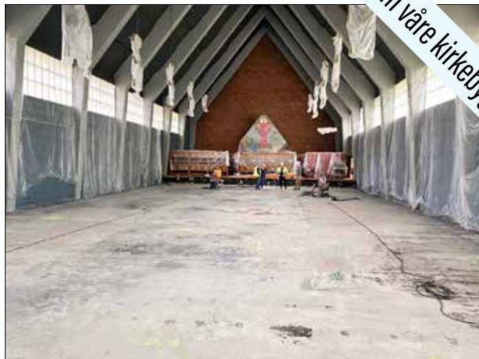
Namsos kirke får vannbåren varme i gulvet fra byens fjernvarmeanlegg og det blir lagt nytt furugulv. En nyoppusset kirke skal etter planen bli ferdig til 15. desember.
