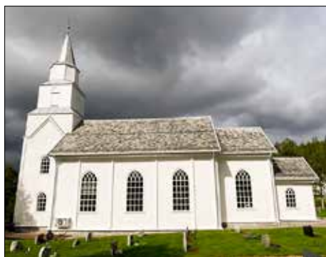
Vemundvik kirke er malebehandlet i sommer. Arbeidet har bestått av vasking, skraping, grunning og 2 strøk maling. Kirka ble sist malt under oppussingen i 2011.
