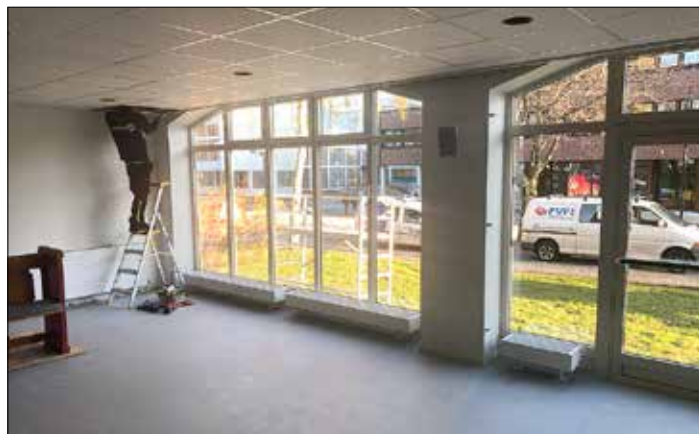
Menighetssalen pusses opp og får hvite vegger, nytt tak med himlingsplater, nytt gulvbelegg og radiatorer med fjernvarme
