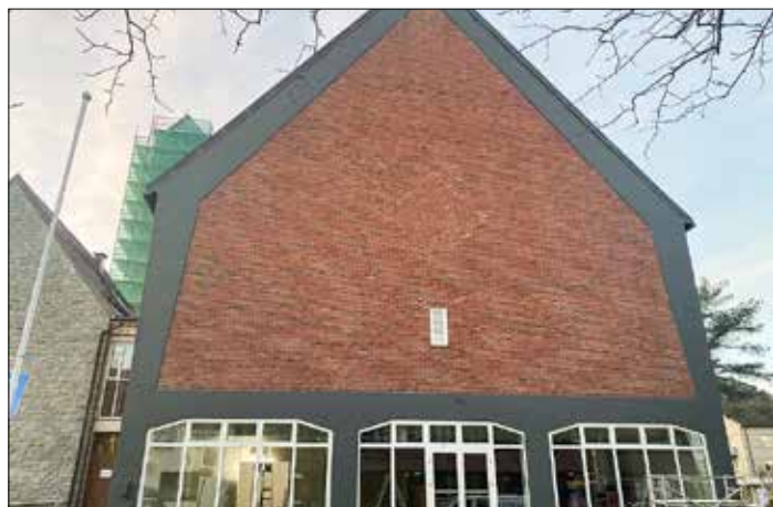
Fasaden mot øst er pusset opp og bærekonstruksjonene malt.
