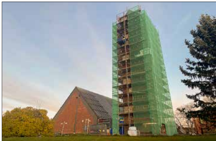
Flatene med murstein og bærende konstruksjoner på vestveggen og tårnet er reparert.
