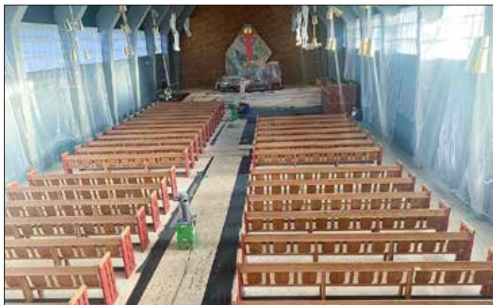
Nytt kirkegulv i heltre med fjernvarme i gulvet er i ferd med å ferdigstilles. I midtgangen og på sidene blir det lagt nye kirkeløpere i samme grønnfarge som den opprinnelige.
