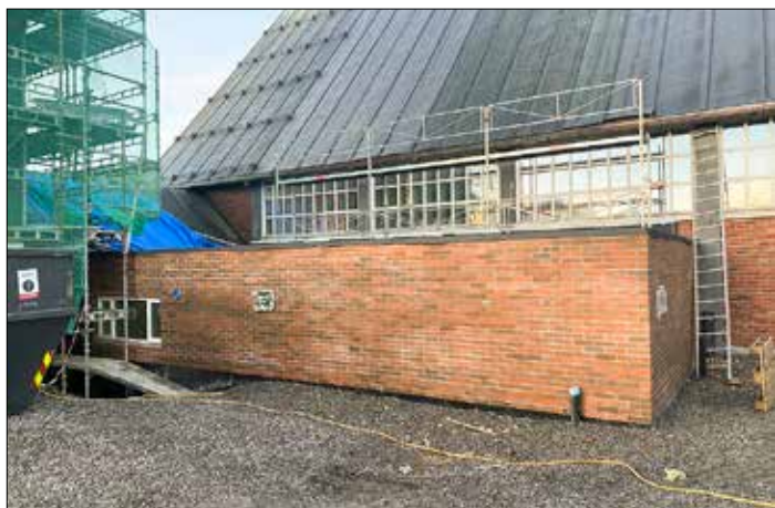
Nytt sanitærtilbygg sett fra utsiden i huken mellom kirkebygget og tårnet. Sanitærtilbygget innredes med 4 toaletter, kjøkken og renholdsrom.
