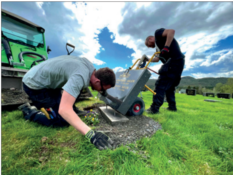
Gravplassarbeiderne Jonas Sylstad og Svein Erik Midtsian under arbeid med steinoppsett i 2022.
