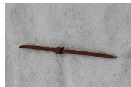
Et for anledningen, liggende ankerkryst på vestveggen.
