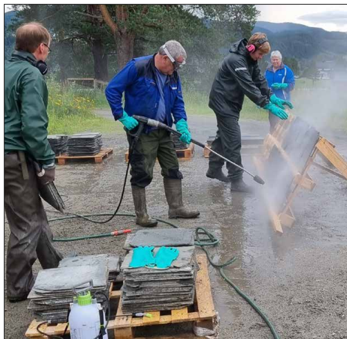
Dugnadsarbeidere vasker takstein sammen med kirketjener Terje Grønnesby.
